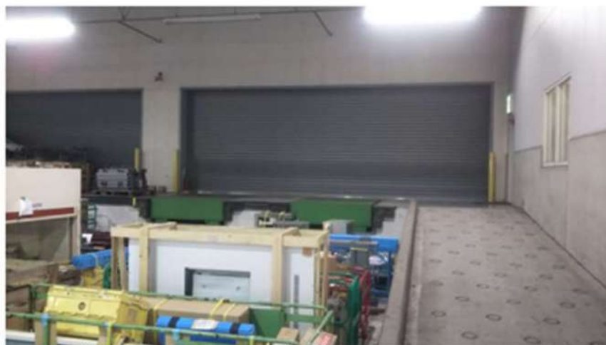
防犯シャッター
